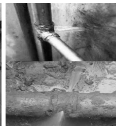
消火用スプリンクラー システム
