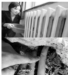
加熱パイプ / 床暖房パイプの漏れ
