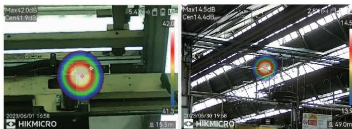
エア漏れ検知
